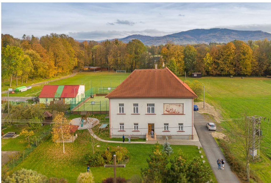
Obrázek 9: Budova bývalé školy
